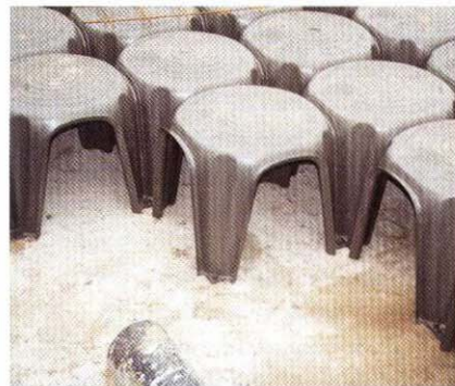
De cassettes op de ondervloer zijn onderling gekoppeld
