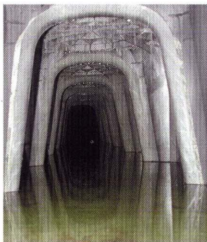
Kijkje onder de vloer
