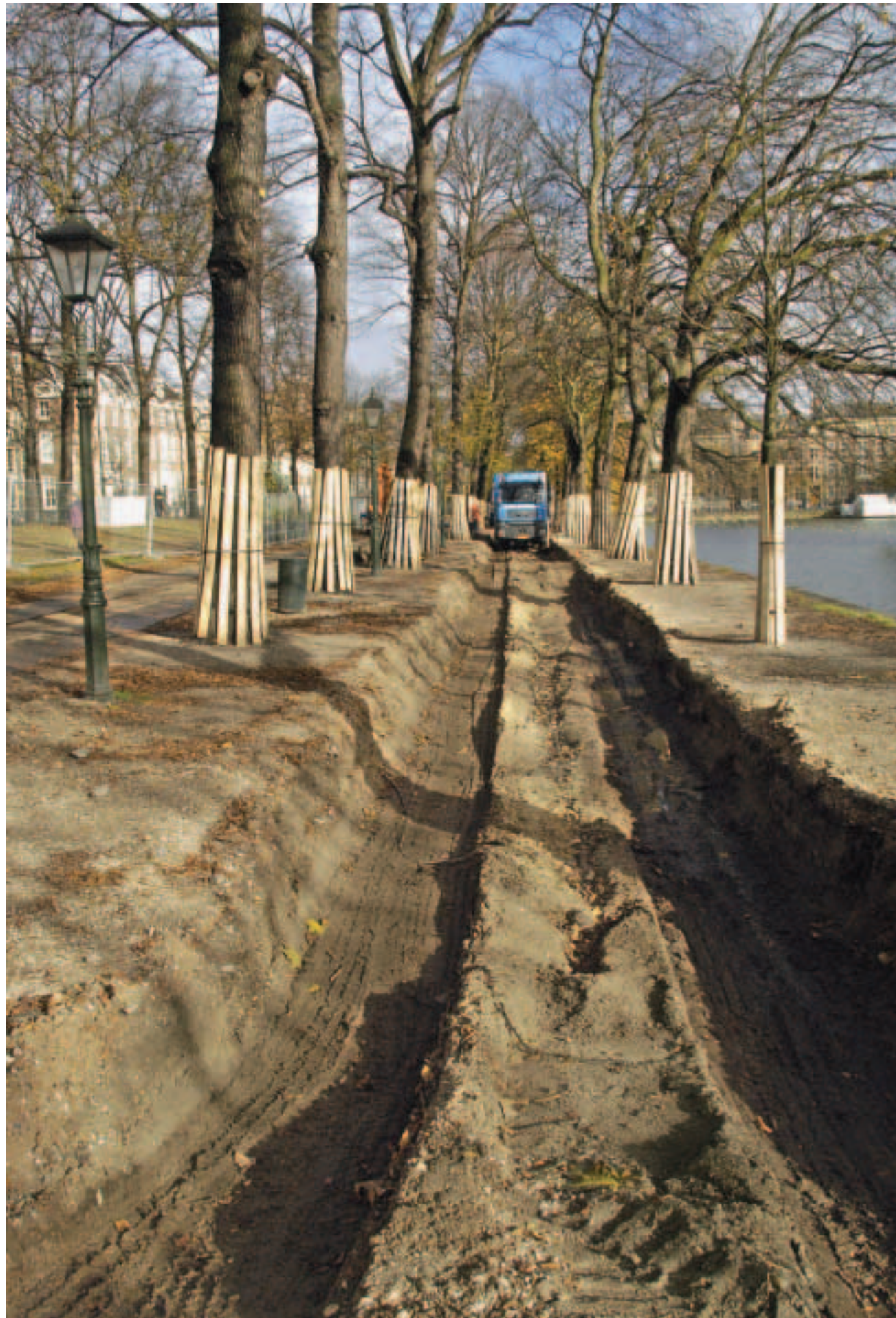
^ Begin november startte de aanleg van de 'bomentunnel'.
