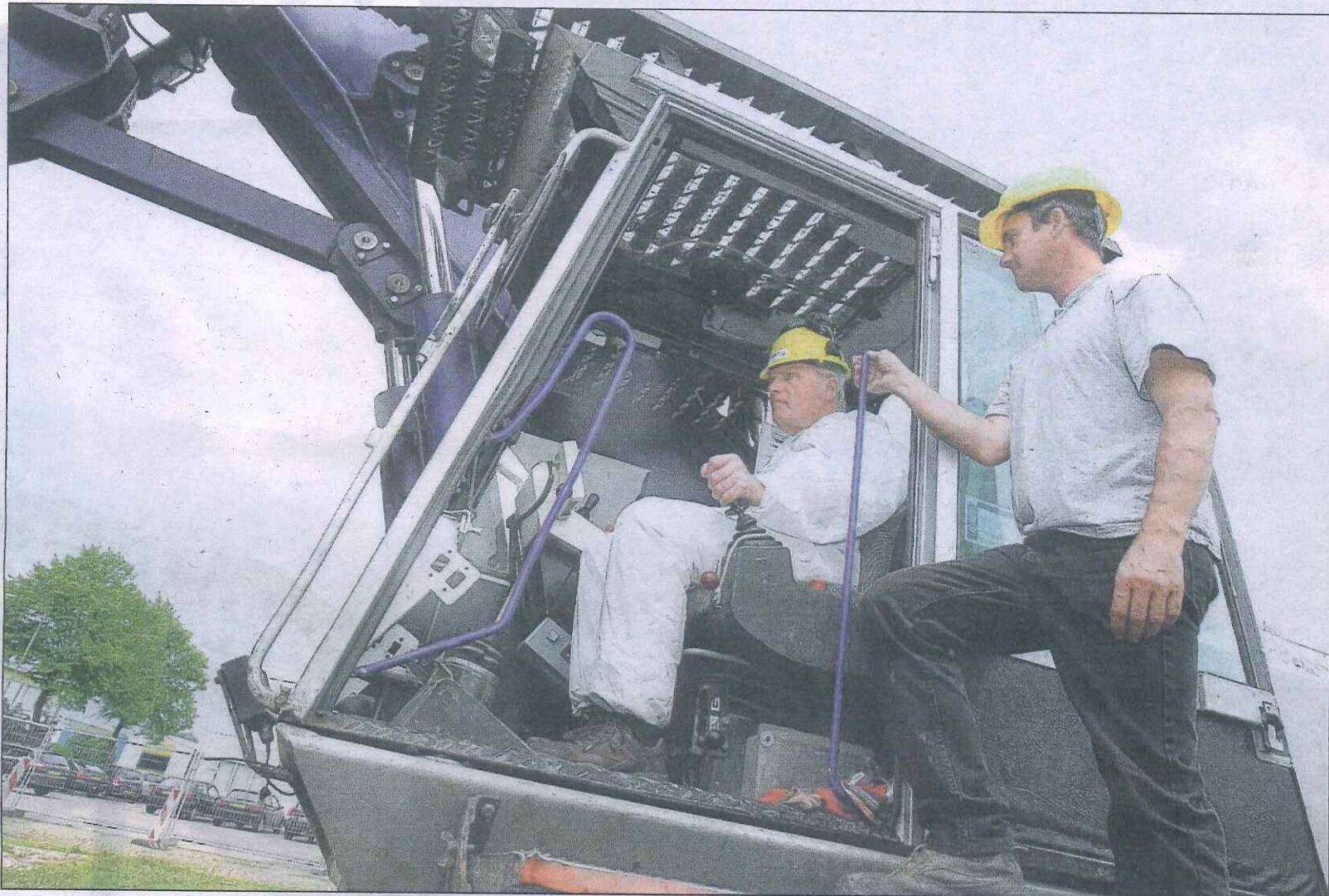
Wethouder Jan Brans klom in de cabine van de machine waarmee de damwanddelen de grond in worden getrild. Een witte overall beschermt zijn kleding.
