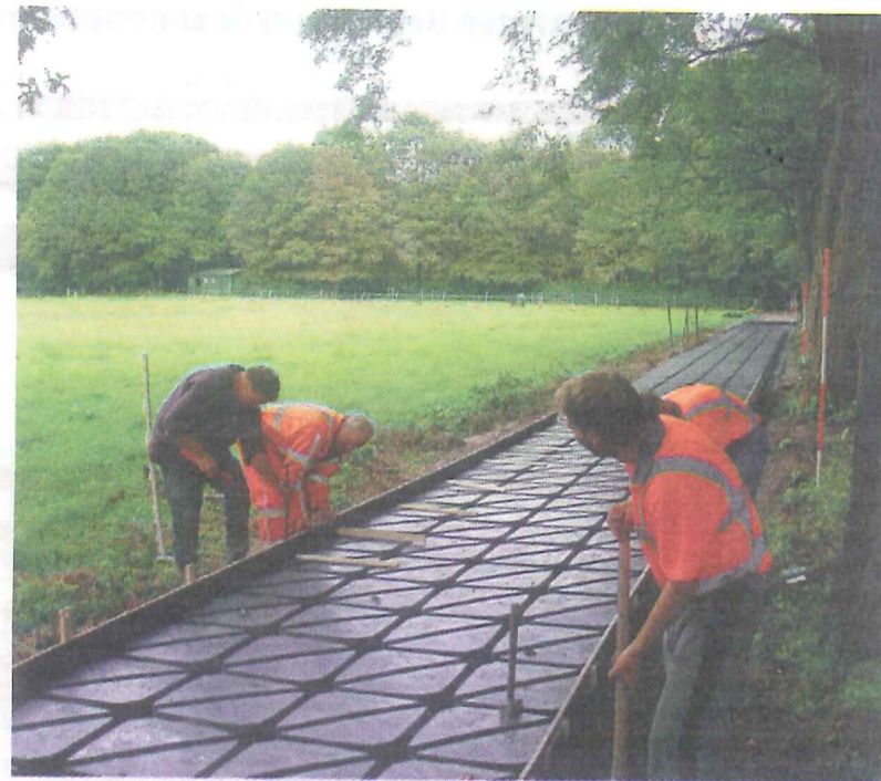
Het fietspad wordt afgewerkt met 12 centimeter beton met één net.
