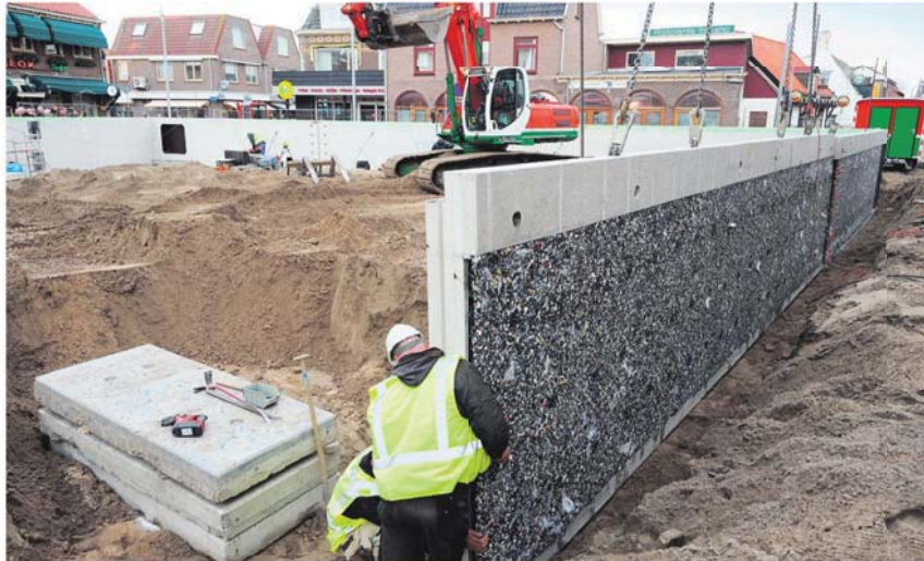
Deze week zijn de wandsegmenten geplaatst. Volgende week gaat de kelder met hydraulische vijzels de grond in.
