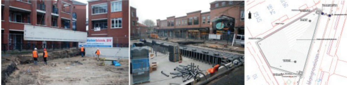
Figuur 11.7 Aanleg bergingskelder Winkelcentrum de Laverije (C) in Rijen, 2011.
