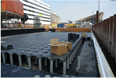
Plaatsing van het Watershell systeem ten behoeve van waterberging.
